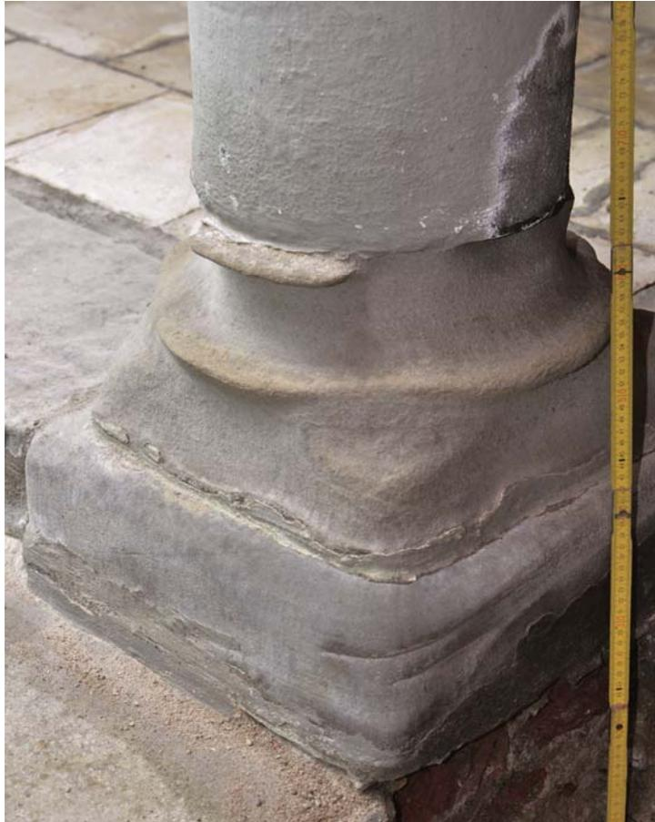
Abb. 15: Durch einen Feuchtestrom aus dem Untergrund wird das Bindemittel in einer Pfeilerbase gelöst und es kommt zum Absanden. Säulenbasis Alter Friedhof Landsber/Lech.
