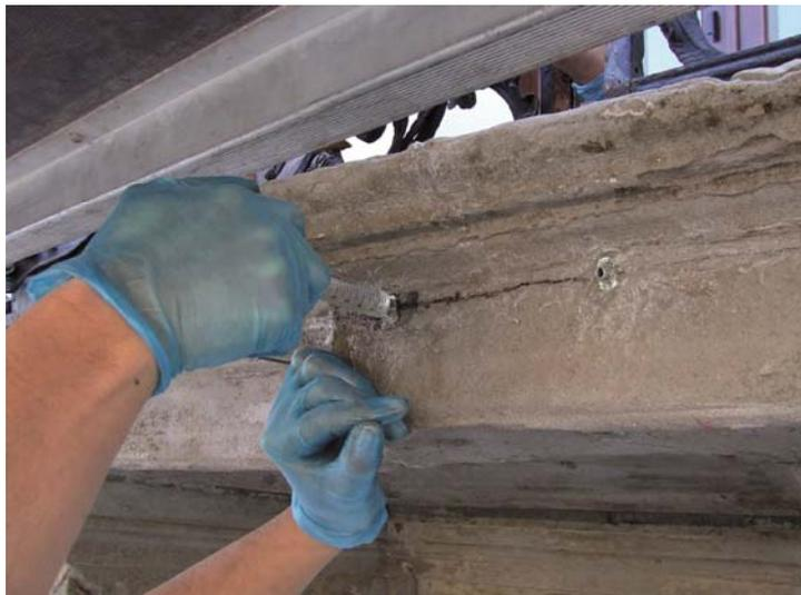
Abb. 22: Rissinjektion über Packer und Spritzen an einer Balkonplatte, Werkstatt Roth
