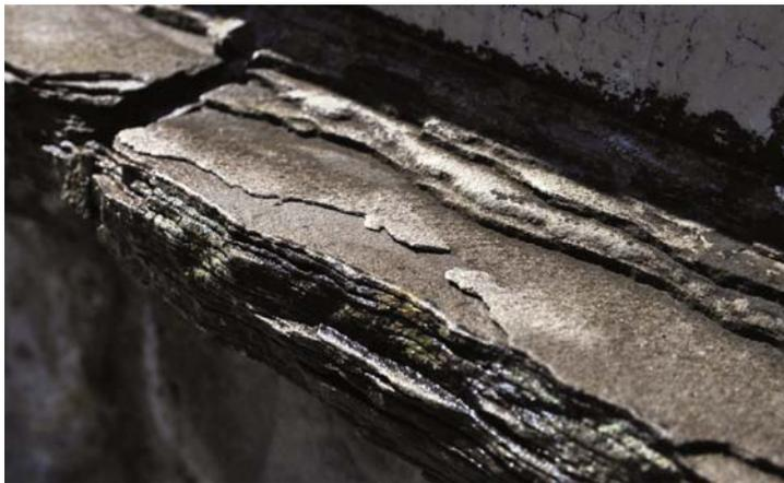
Abb. 13: Abdeckplatten an der Lechbrücke in Lechbruck lösen sich blättereigartig auf.
