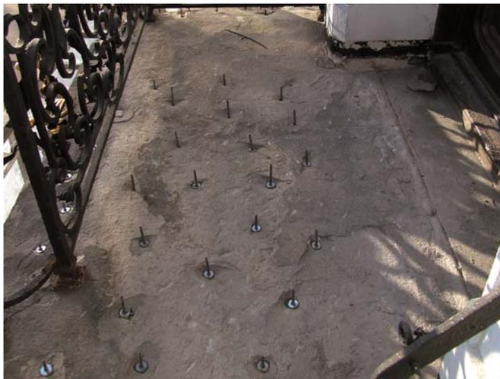
Abb. 33: Einsetzen von Injektionsankern zur drucklosen Injektion einer Balkonplatte, Augsburg
