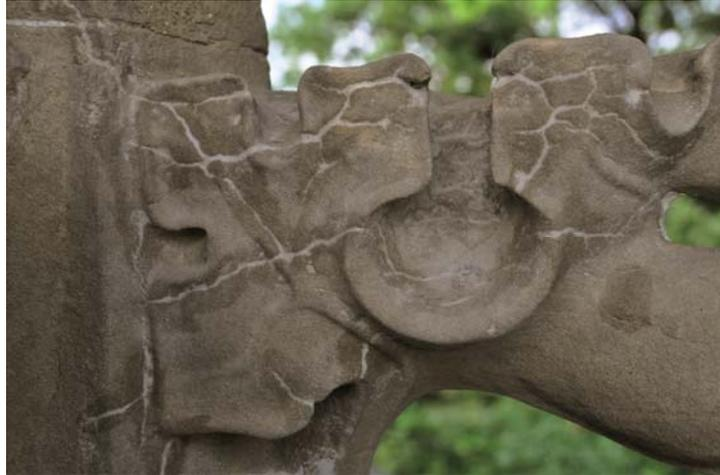
Abb. 23: Ein im KSE-Modulsystem verfülltes Rissnetzwerk, Werkstatt Roth
