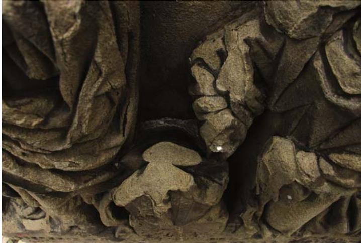
Abb. 10: Abplatzungen durch Materialspannungen und Schalenbildung in einem Epitaph in der Basilika St. Ulrich und Afra, Augsburg
