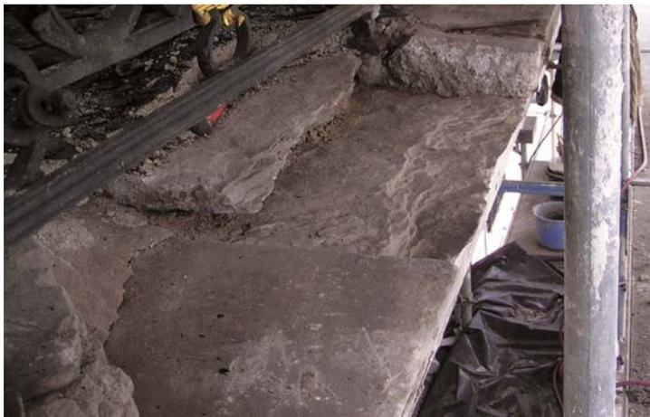
Abb. 14: Aufspalten und Ablösen von Gesteinslagern in einer Balkonplatte von außen nach innen. Schaezlerpalais, Augsburg
